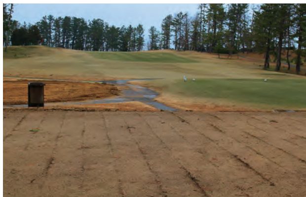
No.9 ホール ティーインググラウンドの改造工事
